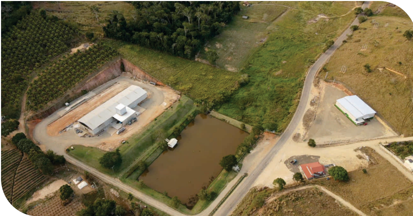
Finalização do armazém de café em Vila Pavão/ES
