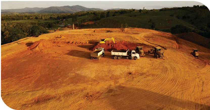
Início da Terraplanagem no Terreno de Camacã/BA
