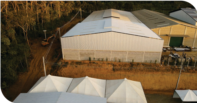
Ampliação do Centro de Distribuição em São Gabriel da Palha/ES
