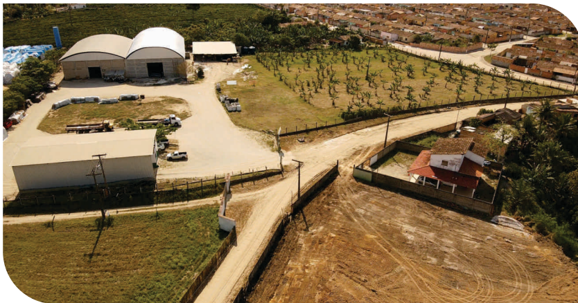
Construção de novo armazém de Adubo em Itabela/BA
